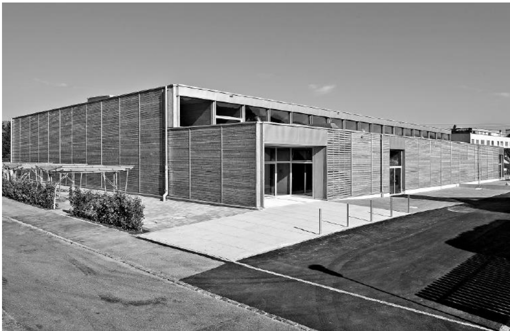
Abbildung B-4: Erweiterung Dreifachturnhalle Gymnasium Thun
